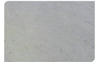
Bề mặt bê tông đạt
