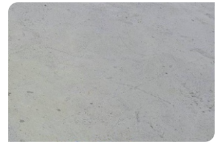
Bề mặt bê tông đạt
