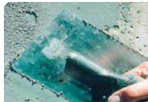
Trám vá bề mặt bê tông bằng vữa sửa chữa Neorep
