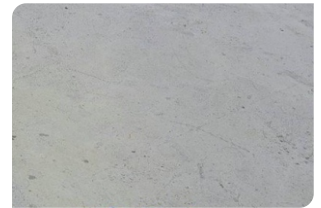
Bề mặt bê tông đạt
