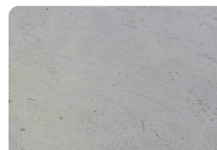
Bề mặt bê tông đạt
