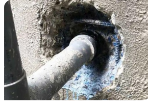
- Vệ sinh, quăn thanh trạng nở - Quét chất kết nối Revinox (pha với nước theo tỉ lệ 1:4)
