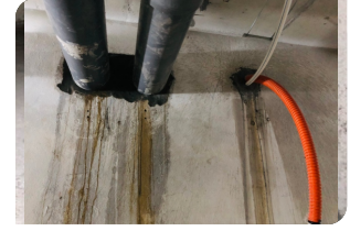
Trám và hoàn thiện bề mặt bằng vữa sửa chữa Neorep
