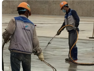
- Vệ sinh, quăn thanh trạng nở - Quét chất kết nối Revinox (pha với nước theo tỉ lệ 1:4)
