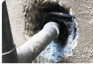
- Vệ sinh, quấn thanh trướng nở - Quét chất kết nối Revinex (pha với nước theo tỉ lệ 1:4)
