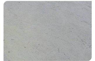
Bề mặt bê tông đạt
