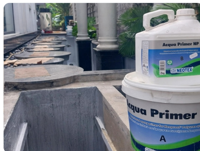
- Vệ sinh, quét thành trướng nở - Quét chất kết nối Revinox (pha với nước theo tỉ lệ 1:4)
