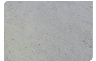
Bề mặt bê tông đạt
