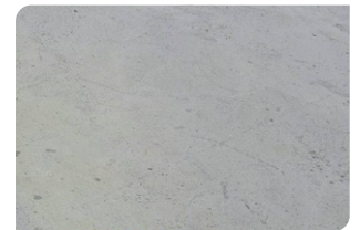
Bề mặt bê tông đạt
