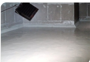
Lắp đặt chuẩn bị đèn chiếu sáng
