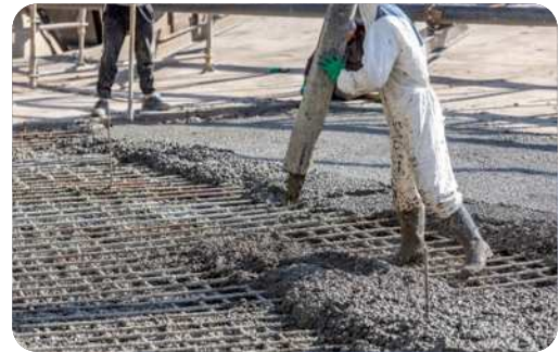
Đổ bê tông sau khi rắc vật liệu tinh thể thấm thấu Neopress® Crystal
