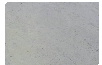
Bề mặt bê tông đạt
