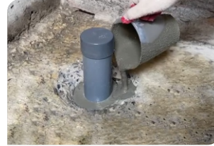
Thi công đổ vữa Lemax Grout LM-G650
