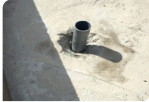
Đục vát quanh cổ ống, chèn xốp hoặc cấp pha bên dưới cổ ống
