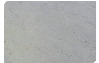
Bề mặt bê tông đạt
