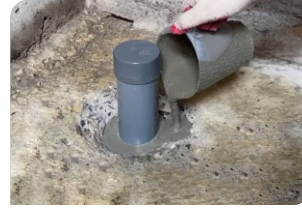
Thi công đổ vữa Lemax Grout LM-G650
