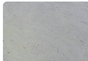
Bề mặt bê tông đạt
