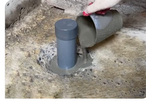
Thi công đổ vữa Lemax Grout LM-G650
