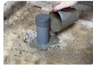
Thi công đổ vữa Lemax Grout LM-G650
