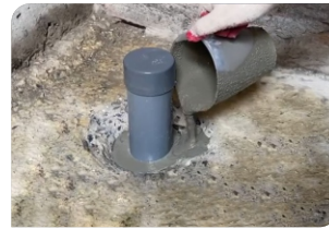
Thi công đổ vữa Lemax Grout LM-G650
