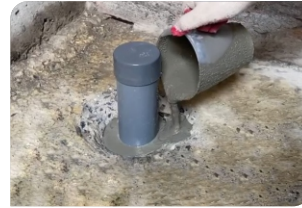
Thi công đổ vữa Lemax Grout LM-G650
