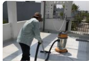
Vệ sinh, trám vá mạch gạch bằng keo trám khe BS 8620S/ Jointex®
