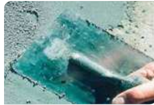
Trám vá bề mặt bê tông bằng vữa sửa chữa Neopre
