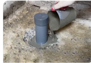
Thi công đổ vữa Lemax Grout LM-G650
