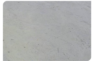
Bề mặt bê tông đạt
