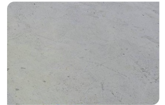
Bề mặt bê tông đạt
