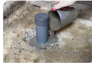
Thi công đổ vữa Lemax Grout LM-G650
