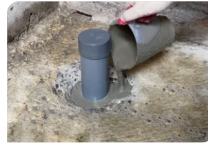
Thi công đổ vữa Lemax Grout LM-G650
