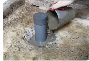
Thi công đổ vữa Lemax Grout LM-G650
