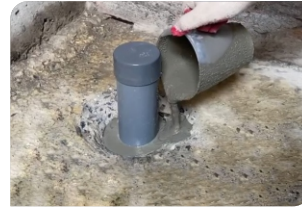
Thi công đổ vữa Lemax Grout LM-G650
