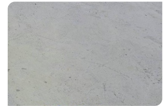
Bề mặt bê tông đạt
