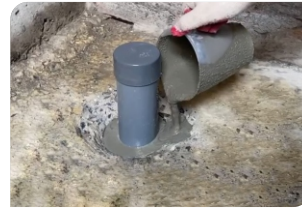
Thi công đổ vữa Lemax Grout LM-G650
