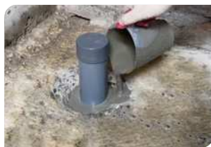
Thi công đổ vữa Lemax Grout LM-G650
