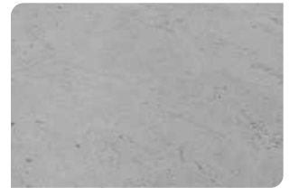
Bề mặt bê tông đạt
