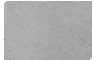
Bề mặt bê tông đạt
