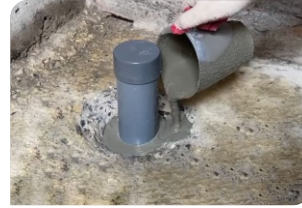
Thi công đổ vữa Lemax Grout LM-G650
