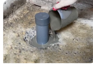
Thi công đổ vữa Lemax Grout LM-G650
