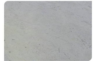
Bề mặt bê tông đạt
