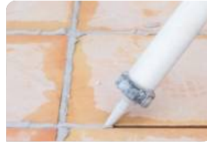
Trám vá mạch gạch bằng keo trám khe BS 8620S/ Jointextm
