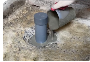
Thi công đổ vữa Lemax Grout LM-G650
