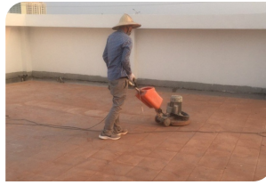
Sử dụng máy mài chà bề mặt gạch đỏ
