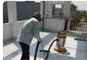
Vệ sinh trám và mạch gạch bằng keo trám khe BS 8620S/ Jointex ®
