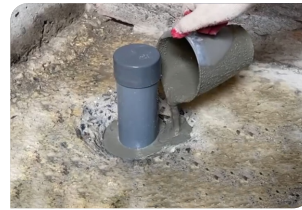
Thi công đổ vữa Lemax Grout LM-G650
