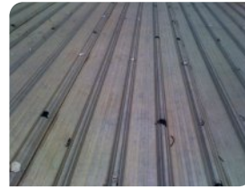
Tẩy rỉ sét mái tôn sử dụng Neodur Metalforce
