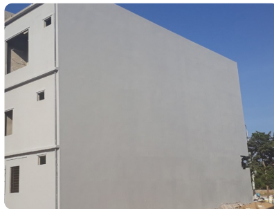
Bước 5: Bề mặt hoàn thiện chờ 7 ngày vật liệu đông kết hoàn toàn, nghiệm thu công trình.
