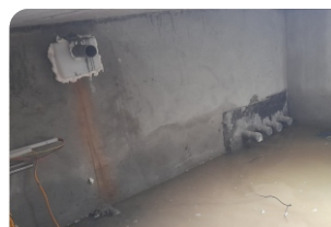
Thi công ghép cấp pha và đổ vữa Lemax Grout LM-G650
