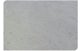
Bề mặt bê tông đạt
