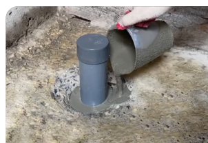
Thi công đổ vữa Lemax Grout LM-G650
