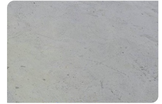
Bề mặt bê tông đạt
