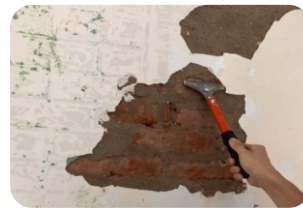
Đóc bỏ toàn bộ lớp vữa tường kém chất lượng
