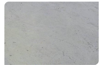
Bề mặt bê tông đạt
