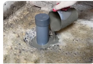
Thi công đổ vữa Lemax Grout LM-G650
