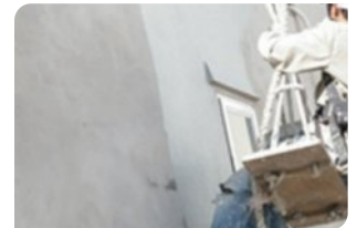
Bề mặt bê tông đạt
