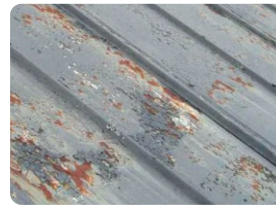
Tẩy rỉ sét mái tôn sử dụng Neodur Metalforce
