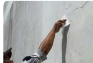
Trám vá khe nứt tường bằng keo trám khe BS 8620S/Jointex
