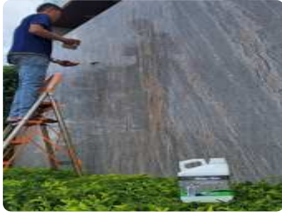
Bước 1: Thi công lớp thứ nhất Silimper® Nano Định mức: 0,1-0,2 lít/m 2
