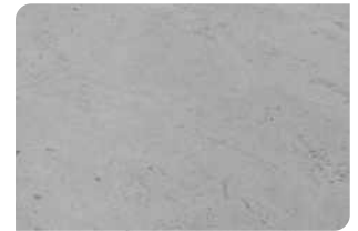
Bề mặt bê tông đạt
