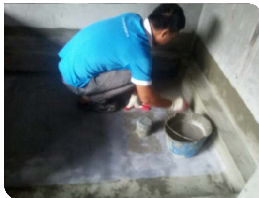
Thi công lớp thứ nhất
