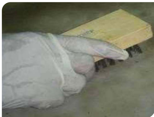
Vệ sinh chuẩn bị bề mặt
