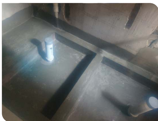
Thi công lớp thứ hai
