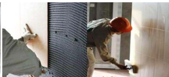
Thi công lát gạch và Chít mạch
