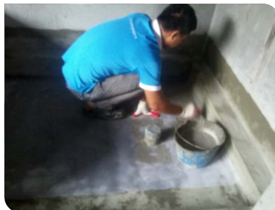
Thi công lớp thứ nhất
