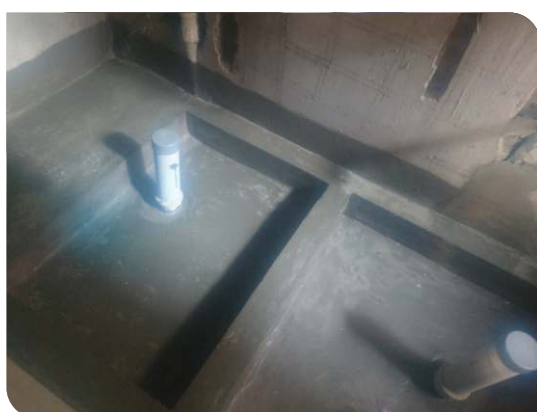
Thi công lớp thứ hai
