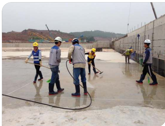
Vệ sinh chuẩn bị bề mặt
