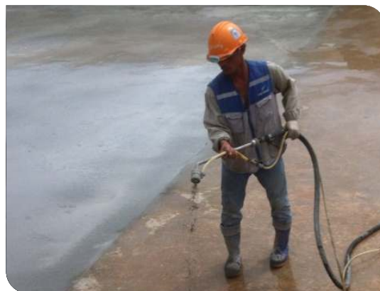
Thi công lớp thứ nhất
