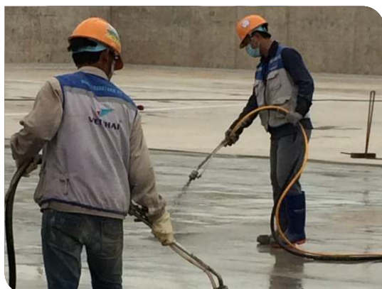
Thi công lớp thứ hai
