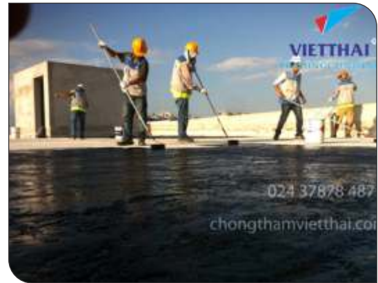
Thi công lăn lớp lót
