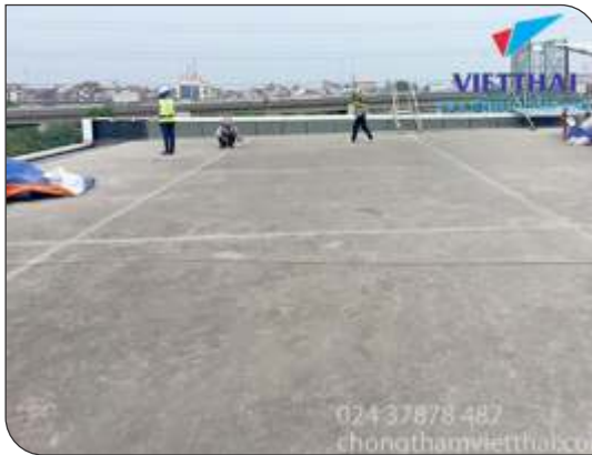
Chuẩn bị bề mặt
