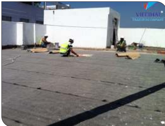
Thi công màng tự dính
