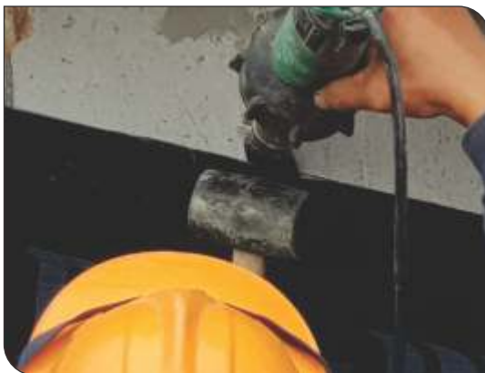
Thi công Hàn chùng mí bằng máy hàn điện
