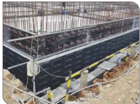
Bề mặt hoàn thiện
