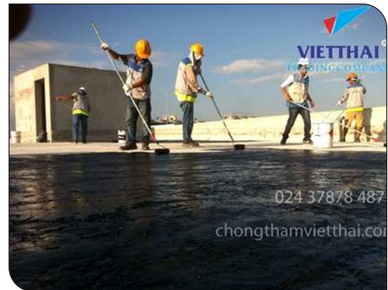
Thi công lăn lớp lót
