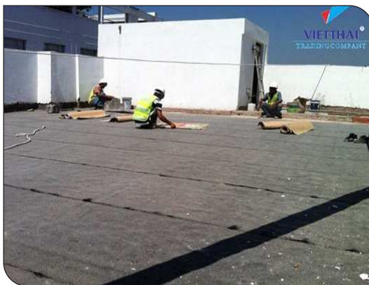
Thi công màng tự dính
