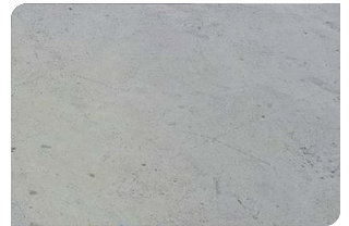
Bề mặt bê tông đạt
