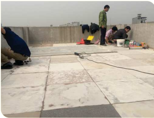
Vệ sinh xịt rửa bề mặt
