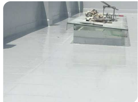
Bề mặt hoàn thiện
