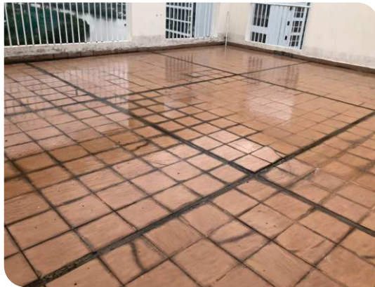
Thi công lớp lót
