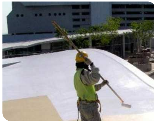
Thi công lớp 1
