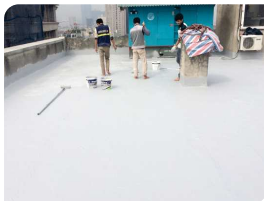
Thi công lớp 2
