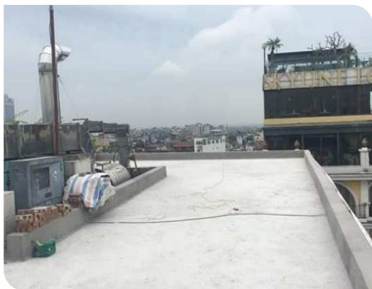
Vệ sinh bề mặt
