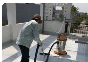
Vệ sinh bề mặt
